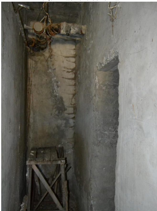
Фото № 5. Помещение № 10 (нумерация в соответствии с техническим паспортом) оцениваемого объекта
