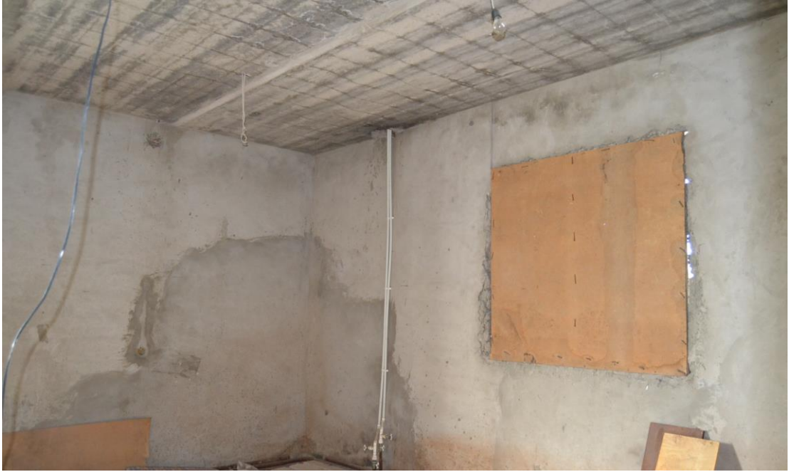
Фото № 6. Помещение № 13 (нумерация в соответствии с техническим паспортом) оцениваемого объекта
