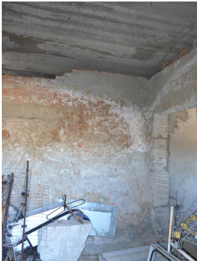
Фото № 3. Помещение № 9 (нумерация в соответствии с техническим паспортом) оцениваемого объекта
