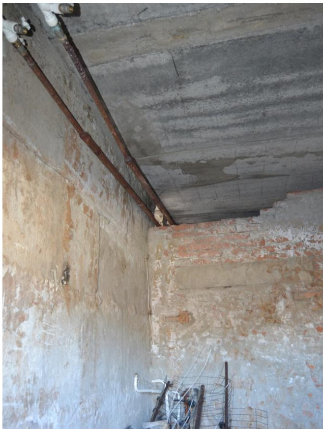
Фото № 4. Помещение № 9 (нумерация в соответствии с техническим паспортом) оцениваемого объекта
