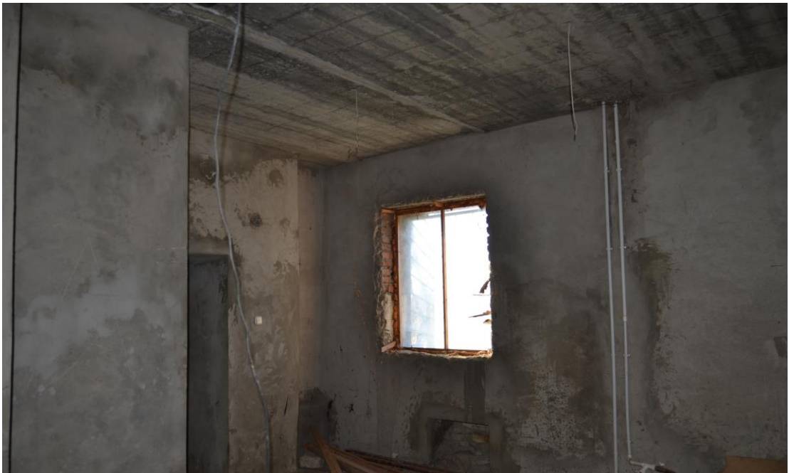
Фото № 7. Помещение № 13 (нумерация в соответствии с техническим паспортом) оцениваемого объекта
